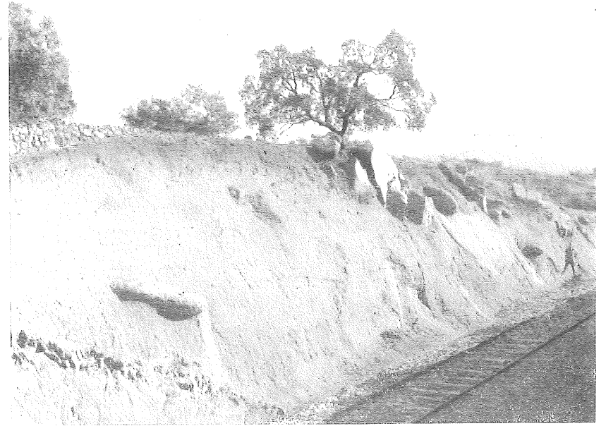
Fig. 1.—Macizo diorítico en la trinchera del ferrocarril de Zafra a Jerez de los Caballeros, casi totalmente alterado, destacando en su masa los núcleos rocosos inalterados. Se aprecian también los filoncillos de rocas aplíticas y gábricas que atraviesan la masa general. Inmediaciones del contacto con materiales calizos cambrianos. Vista al Noreste. Diciembre de 1935.
