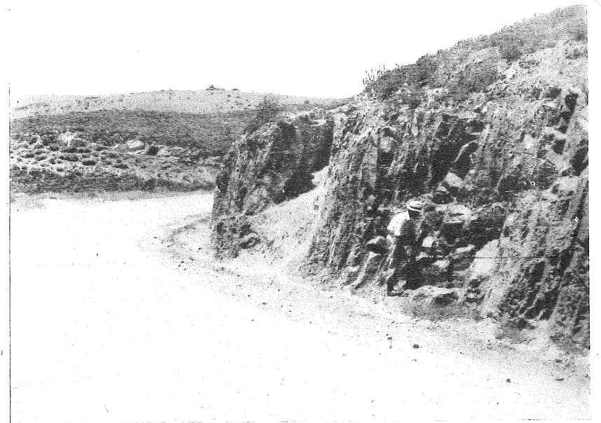
Fig. 2.—Alineación de cuarcitas ordoviccienses cortada por la trinchera de la carretera de La Lapa en el Km. 5-6. Corren las cuarcitas al Noroeste sensiblemente verticales, estando afectadas por una falla local vertical, orientada sensiblemente de Este a Oeste. Vista hacia el Oeste. Junio de 1952.
